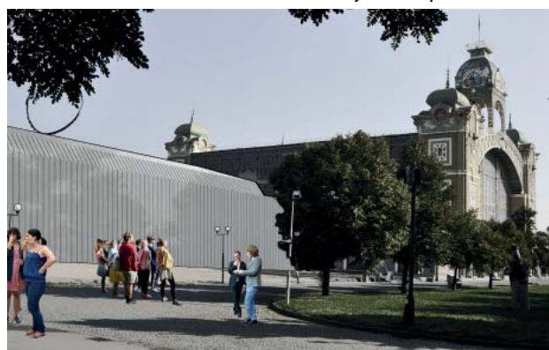
OBR 005 Dočasné zastřešení - typizovaná montovaná hala
